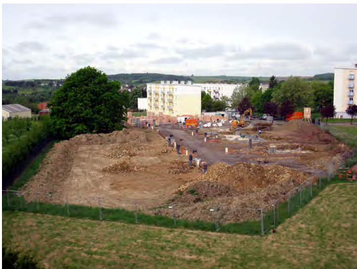
La nouvelle voie qui dessert cet aménagement se nomme "impasse Théodore GOUVY"
