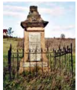
Le calvaire avant travaux
